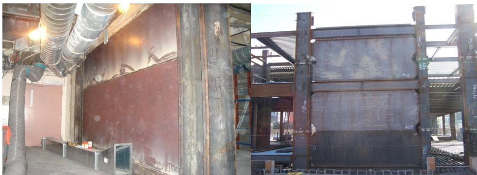
شکل ۷-۸: نمونه اجرایی دیوار برشی فولادی
