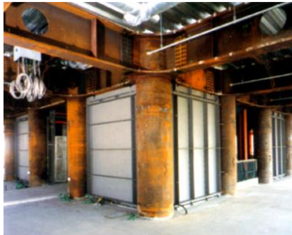
شکل ۵-۱: دیوار برشی فولادی با سخت‌کننده‌های افقی و قائم
