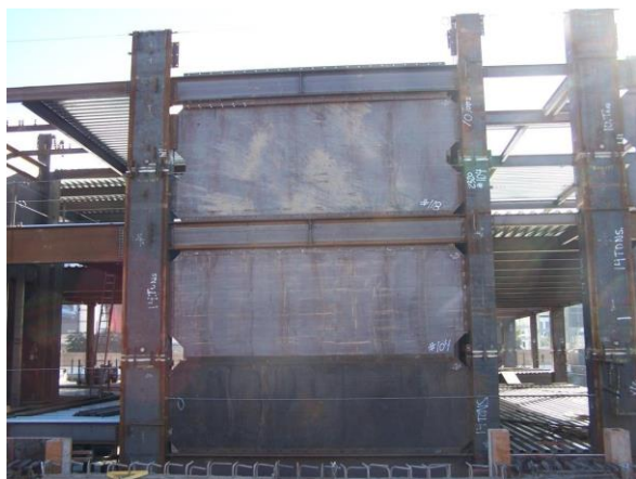
شکل ۲-۵: نمونه‌های اجرایی دیوار برشی فولادی [11]
