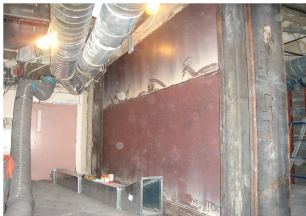
شکل ۲-۵: نمونه‌های اجرایی دیوار برشی فولادی [11]
