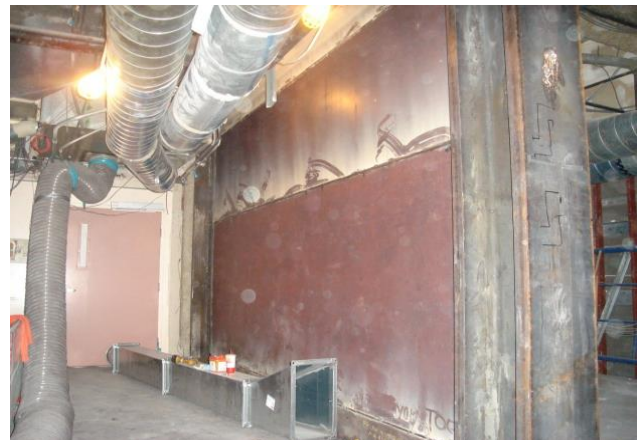
شکل ۲-۵: نمونه‌های اجرایی دیوار برشی فولادی [11]
