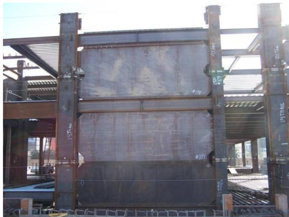
شکل ۲-۵: نمونه‌های اجرایی دیوار برشی فولادی [11]
